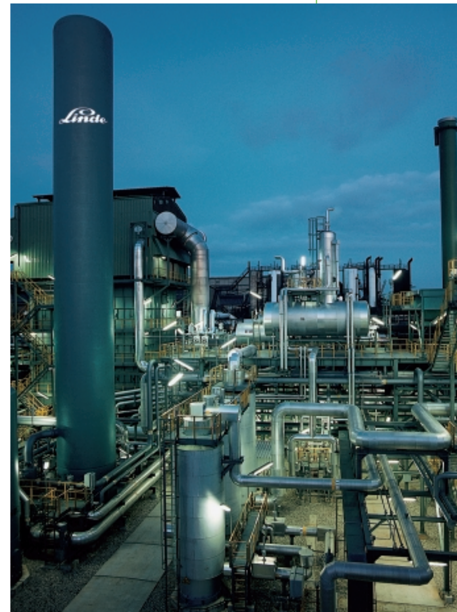
Steam-Reformeranlage, Leuna / Deutschland; Quelle: Linde AG
