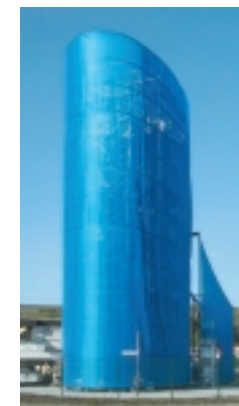
Der „Blaue Turm“: Versuchsanlage zur Gestuften Reformie- rung biogener Rest- stoffe
