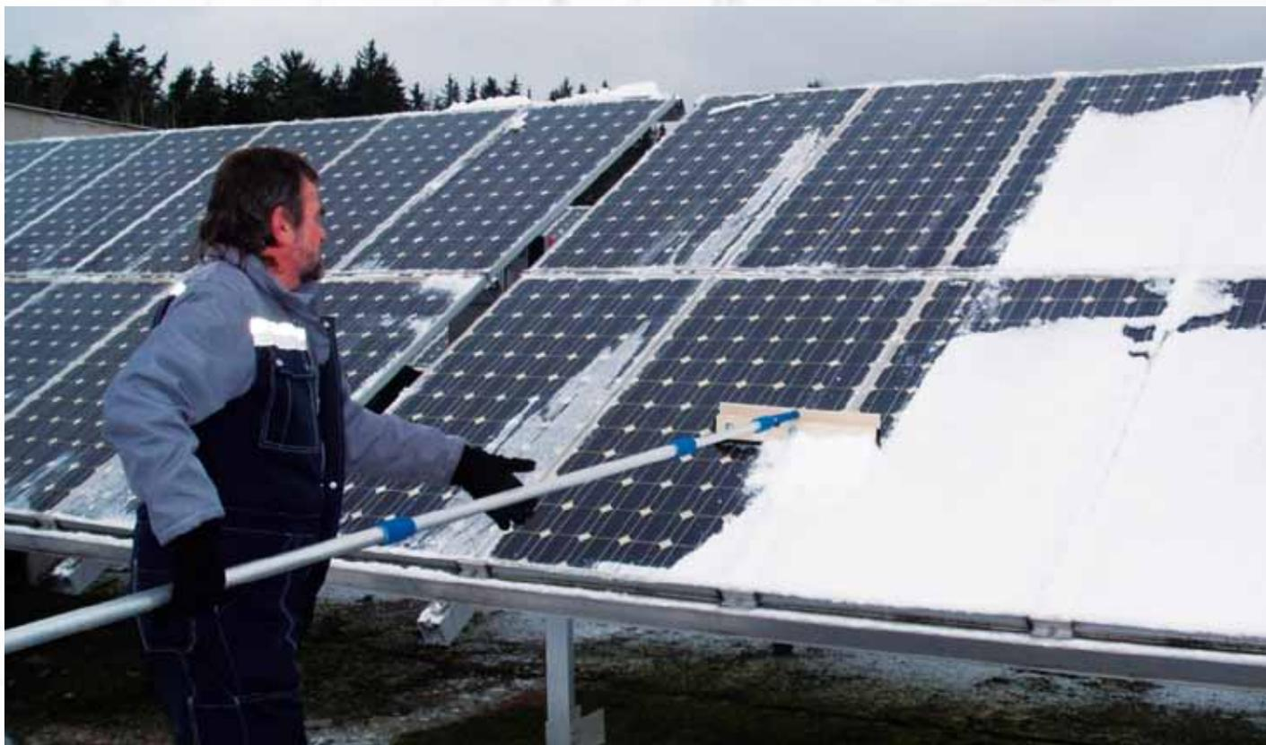
Abb. 2: Der Wartungsmitarbeiter beim Schneeräumen mit entsprechendem Räumungsgerät. Da dies einmal täglich durchgeführt wurde (sofern es zwischenzeitlich geschneit hatte), konnte es vorkommen, dass die Module kurz nach dem Freiräumen erneut zugeschneit wurden. In diesem Fall lag der Schnee bis darauffolgenden Tag. Außerdem wurde an gesetzlichen Feiertagen (z.B. Weihnachten) und an Sonntagen kein Schnee geräumt.
