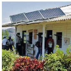
400 Wp zur Versorgung mit Licht, TV-Set, Kühlgerät und Funkgerät.
