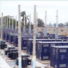
Für eine sichere Stromversorgung wurde der dezentrale Dieselgeneratoren installiert.
