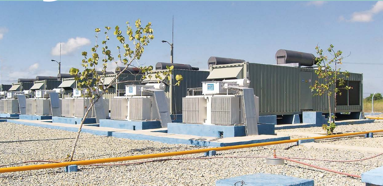
Für eine sichere Stromversorgung wurde der dezentrale Dieselgeneratoren installiert.
